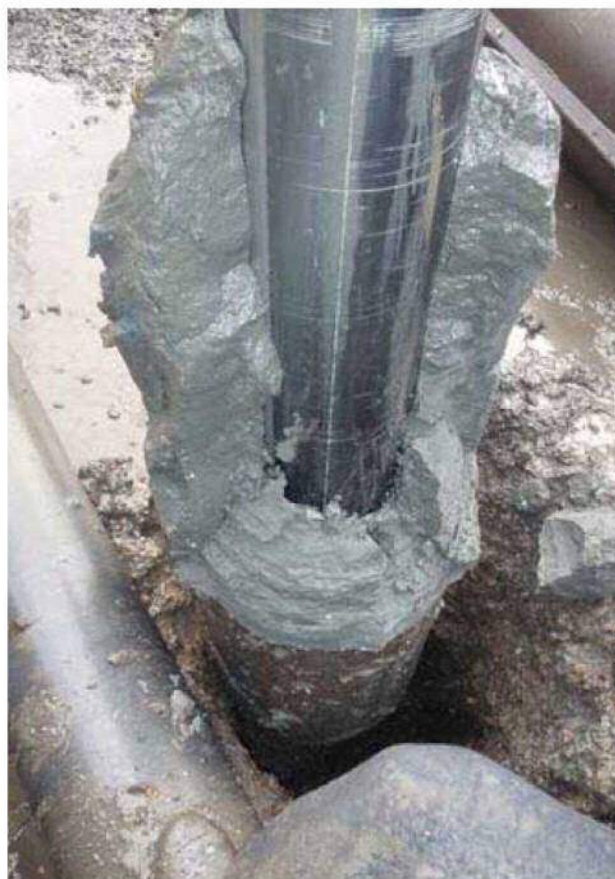
切断により補修地盤の内部を確認。
