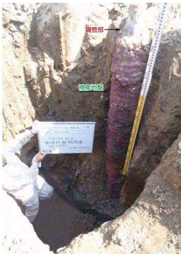
フェノールフタレイン溶液の吹付により、補修地盤の範囲を確認。
