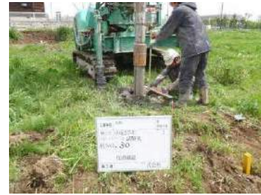
AQパイロ杭頭高さ確認
