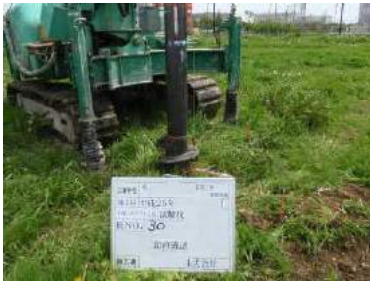
所定位置にAQパイロ施工
