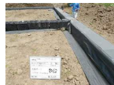
天板(リブラボード®)設置
