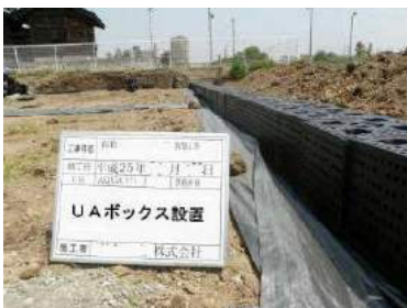
透水シート敷設後UAボックス設置
