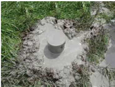
AQパイロ施工確認
