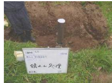
AQパイロ杭頭錆止め処理
